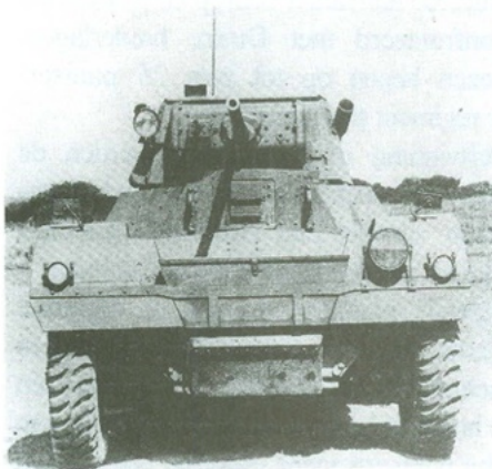
Drie verschillende aanzichten van de Armoured Car, Daimler Mk.I Duidelijk herkenbaar zijn de compactheid (minder van vier meter lang) en de kleine Tetrarch toren met het 2 pponder kanon en de coax mitrailleur.
